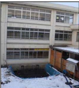
給食リフトの工事
