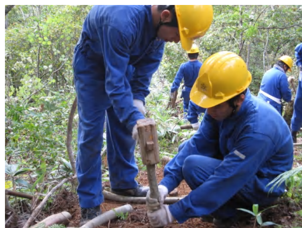
まず、杭を打って階段の土台を作ります。
